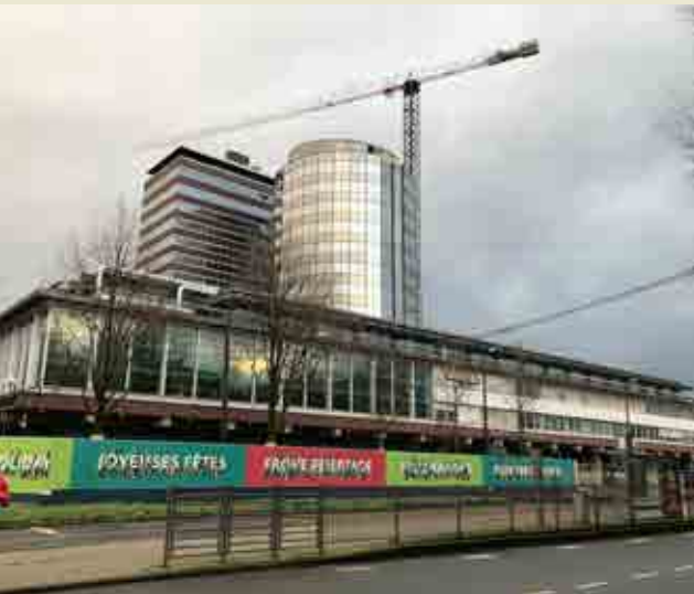
Amsterdam Centrum, Westeinde 1, renovatie
