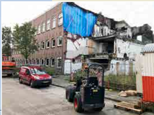
Hilversum, Amperestraat 10, sloop voor woningbouw
