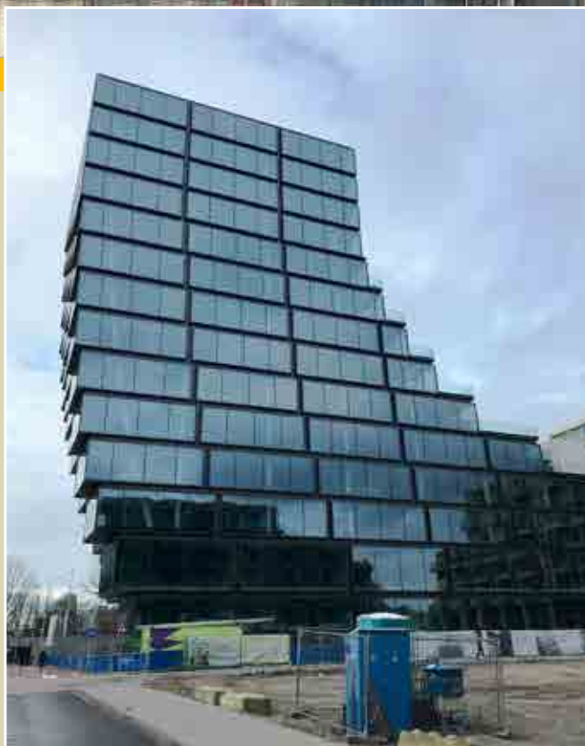
Amsterdam Zuid, Gelrestraat 16, Terrace Tower
